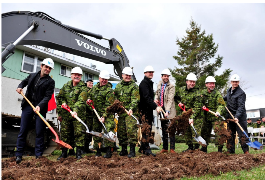
Une première pelletée de terre a été soulevée pour souligner le début des travaux de construction du nouveau manège militaire du 35 e RGC à Sainte-Foy. Photo Lt Isabelle Provost
