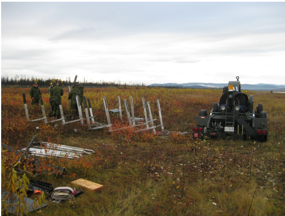
Des tech de la 86 ESPA installent la ligne de piquets KM pour fixer le SAA mobile lors d'engagements d'aéronefs
