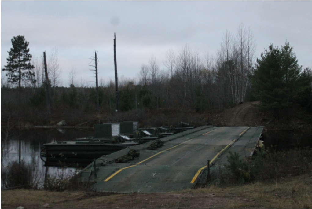
Le pont terminé, à Mount Batten.
