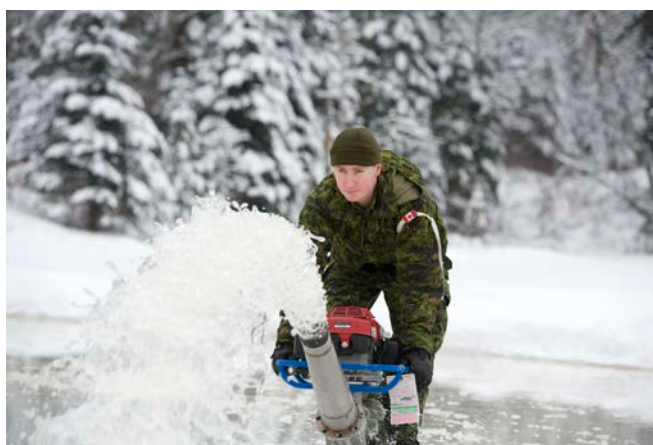
Le Sapeur Maxime Thibault arrose la glace pour augmenter la capacité portante du pont et permettre la traversée de véhicules. Photo : Lt Isabelle Provost
