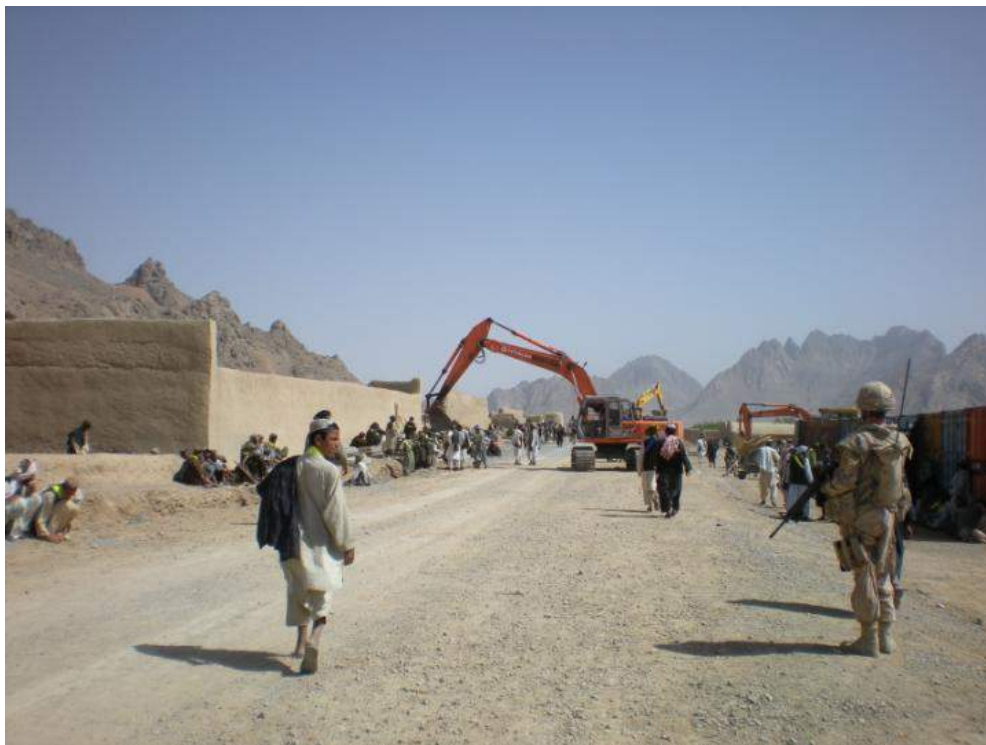
EGC 1 travaille à l'agrandissement de la route Fosters dans le district de Panjwayi
