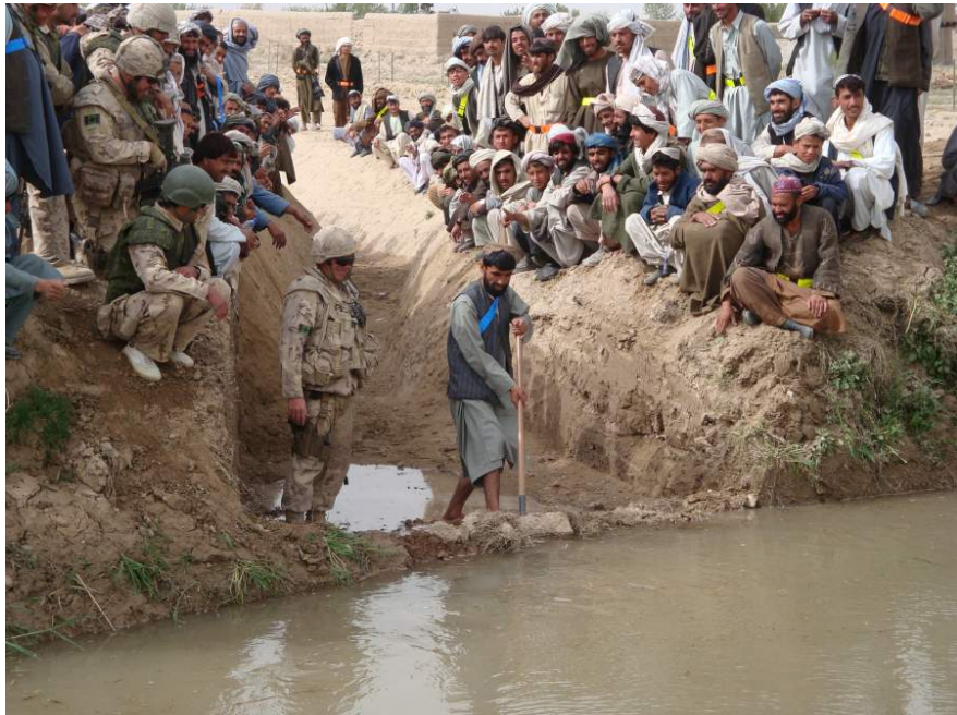
EGC 2 ouvre un nouveau fossé d'irrigation qui a construit dans la communauté de Pashmul du district Zahrey, au début du printemps 2009
