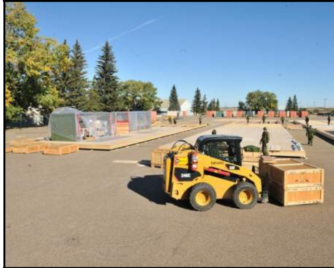
Construction de la la cuisine du CTD pouvant accueillir mille personnes
