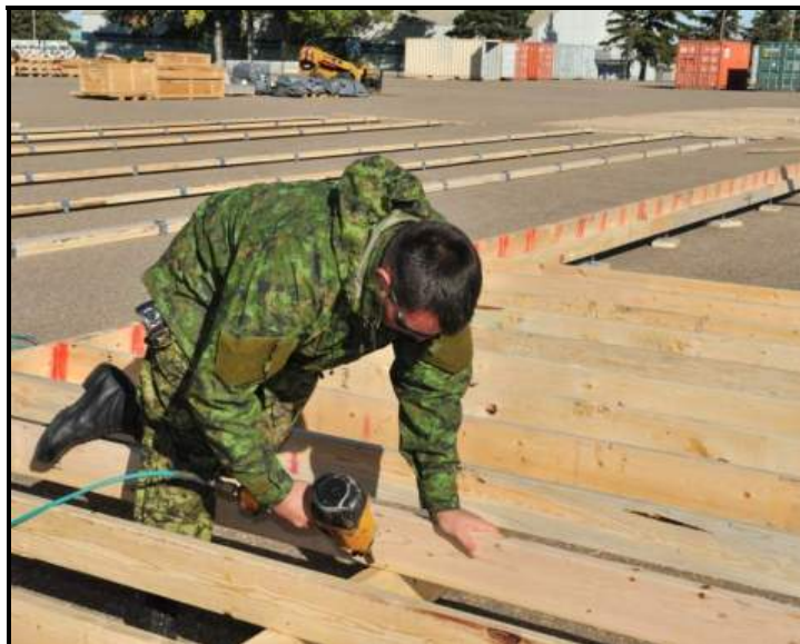
Le Cpl Shawn Eddison, un technicien de construction, assemble le plancher de la cuisine du CTD
