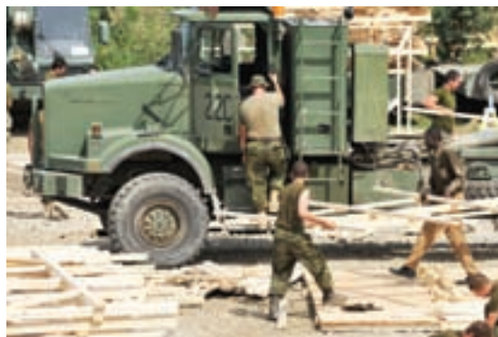
Des militaires du groupement tactique du 3 e Bataillon, Royal 22 e Régiment, et un menuisier haïtien construisent des abris temporaires pour les habitants de Léogâne, à Haïti, au camp Chimo.
