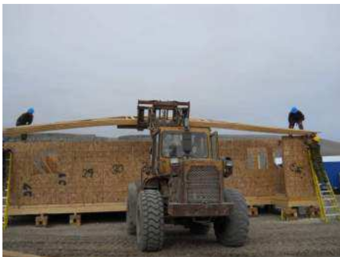
Les Caporaux-chef Andrew MacDonald et Andrew Fraser, d'Esquimalt (C.-B.) ainsi que le Sgt Donald O'Connell de Moncton (N.-B.) installent des fermes sur les Panneaux sandwich Isolants.
