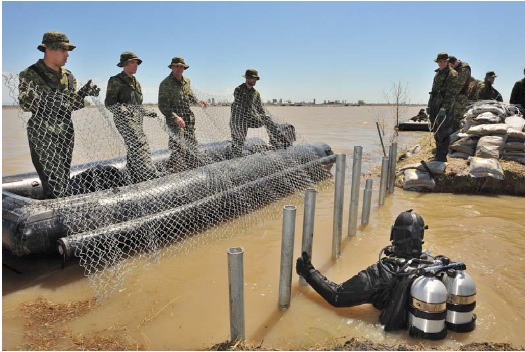
Des membres de la Cie C du 2R22R martèlent les poteaux de soutiens à bord de bateaux d'assaut n'utilisant que des camouflettes. Source : Caméra de combat
