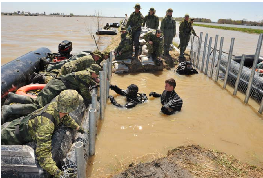
Les plongeurs du 5RGC et de la réserve navale aidés des membres de la Cie C du 2R22R s'affèrent à la fixation de la clôture aux poteaux de soutiens. Source : Caméra de combat
