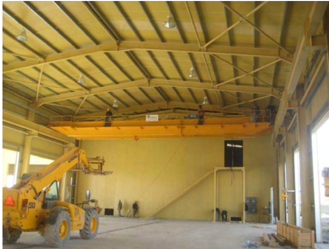
Installation d'entretien à l'aérodrome de Kandahar.
