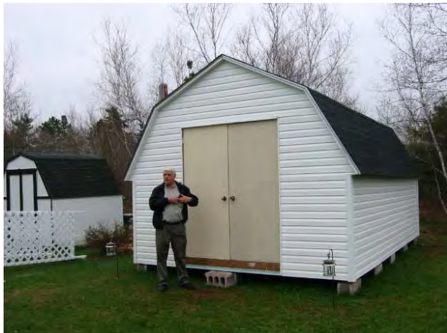
Les matériaux provenant des logements du MDN ont été utilisés pour construire des remises à Greenwood, N.-É.
