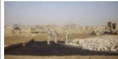
Une toile de géotextile permet une durée de vie accrue aux routes et permet à celles-ci de supporter de plus grandes charges.
