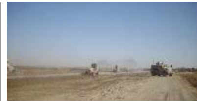
Les véhicules des ingénieurs étalent le gravier à la base de la route.
