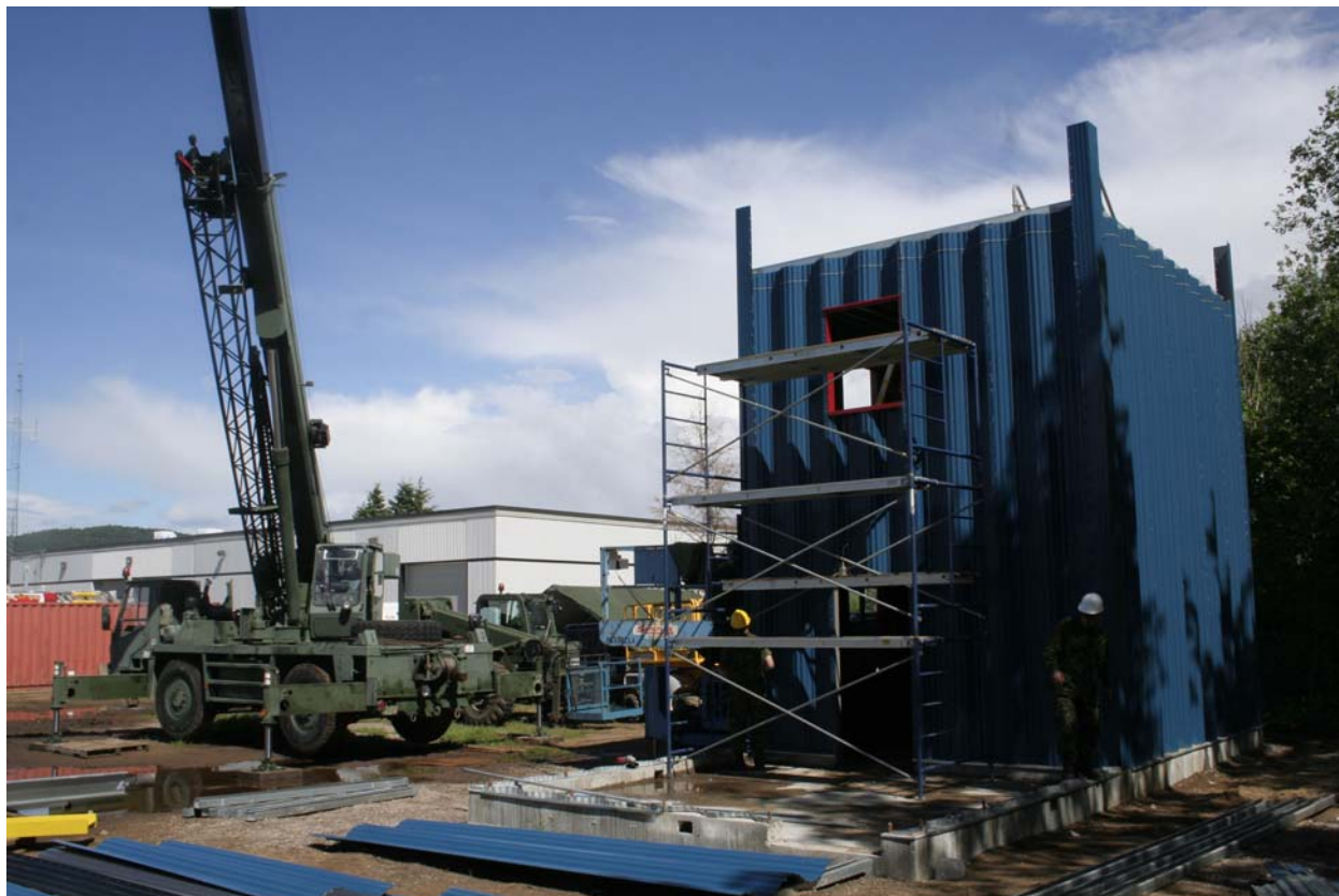
Des ingénieurs de la troupe de construction du 5 e Régiment du génie de combat et de l'Unité d'appui du génie 3-10 construisent une tour d'entraînement de quatre étages pour les pompiers de la Garnison Valcartier, derrière la caserne. En date du 7 juin, les ingénieurs avaient érigé deux étages de la structure.
