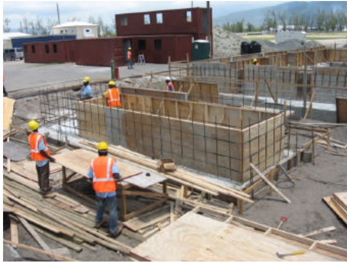
Chantier de construction au camp Alpha-Un
