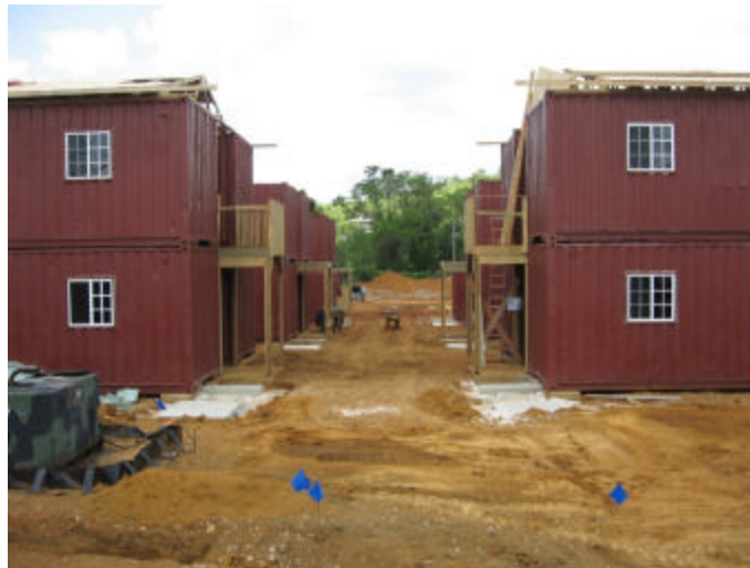
Chantier de construction au Camp Moneague
