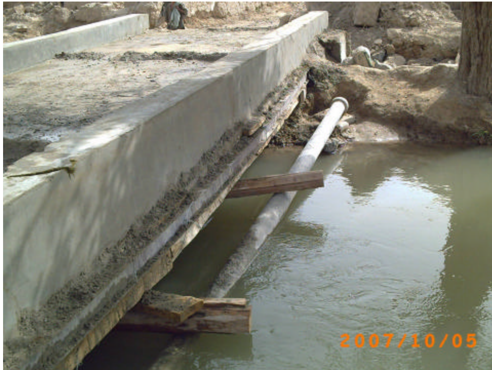
Coffrages et supports de béton utilisés pendant la construction et la cure du pont à dalles de béton. Ces éléments sont typiques des constructions à Kandahar.
