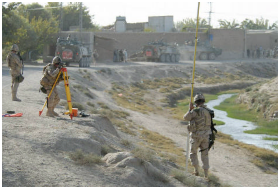
Le Sgt Erskine et le Sgt Vezeau, ingénieurs de l'EPR, mesurent les distances et les élévations afin de déterminer l'envergure du futur pont à Kulchlabad, dans le district de Dand.
