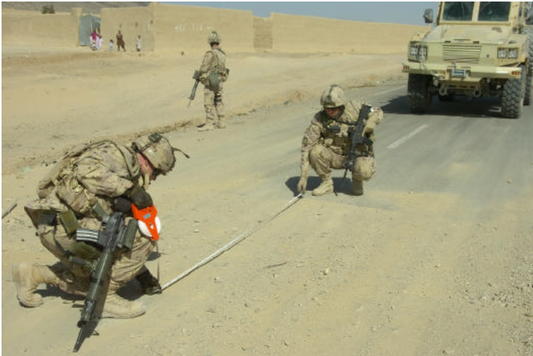
L'Adjudant-mâitre Tom Gardner (3 e ESG) et le Caporal-chef Leclerc (compagnie D du R22 e R) mesurent la largeur d'un morceau de la route endommagée le long d'un itinéraire principal de ravitaillement dans le district de Panjwayi.
