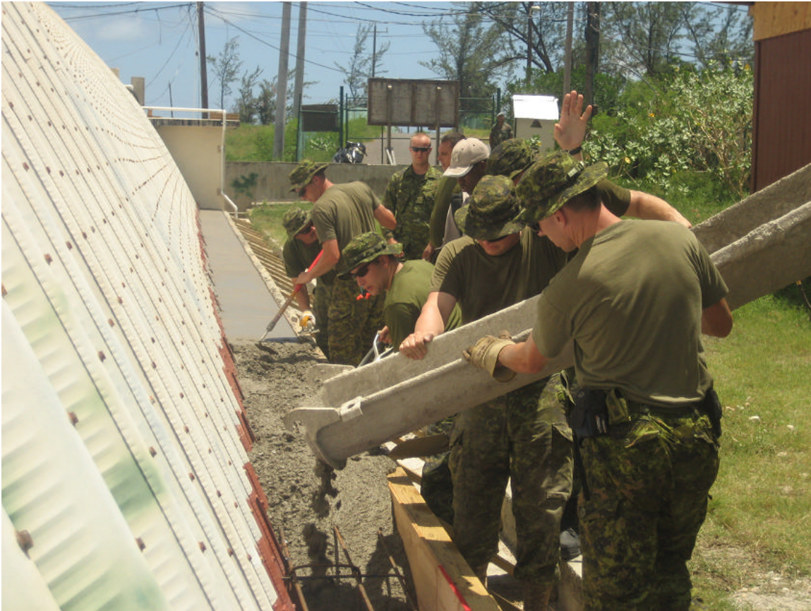
Des membres de la 1 ère Troupe de construction du secteur coulant du béton dans le cadre des travaux de réparation du hangar destiné à l'entretien des aéronefs.
