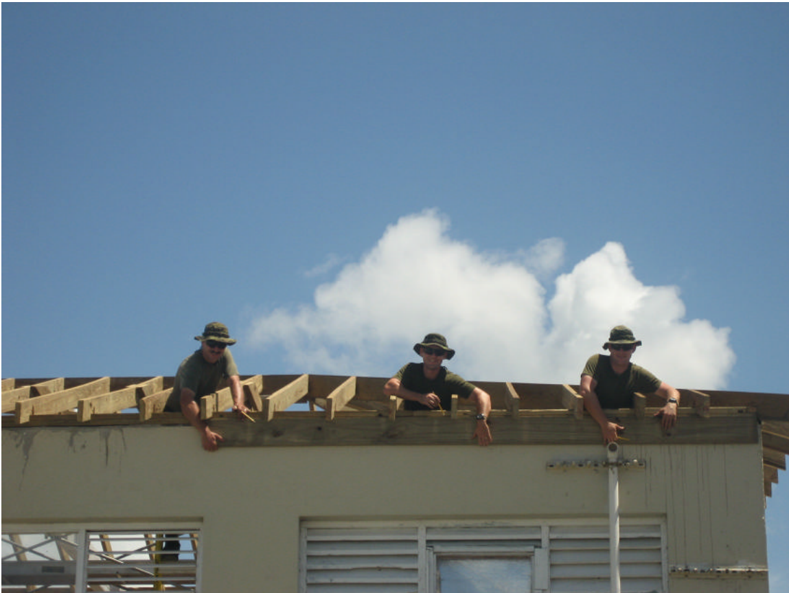
Cpls Butt, Best et Turner. Construction d'un nouveau toit.
