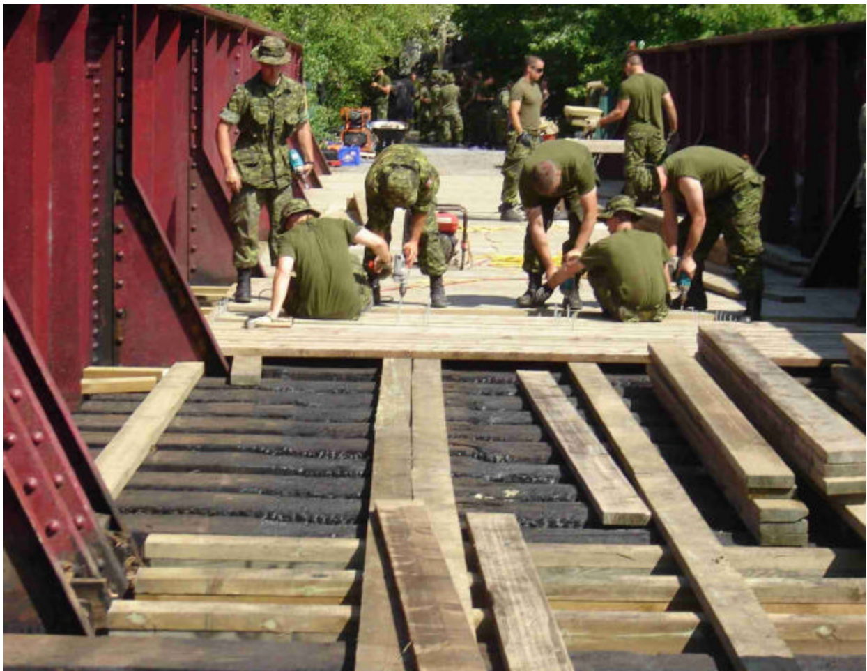
Des étudiants en génie de combat de la BFC Gagetown fixent le nouveau tablier du pont du Sentier d'Oromocto. (photo : Sap J. Strange)
