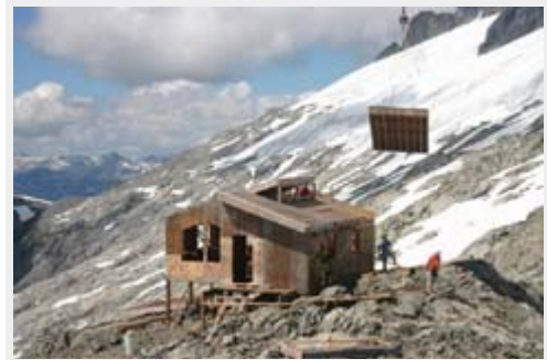
Des bénévoles civils regardent un réserviste de la 192 Escadrille du génie de l'air d'Abbotsford guider l'installation d'un panneau de pavillon sur le refuge des alpinistes qui est en voie de construction au sommet d'une chaîne de montagne côtière en Colombie-Britannique.
