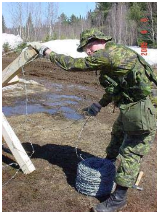
Slt Jeff Day qui construit un tétraèdre pour assurer la sécurité de la grille.
