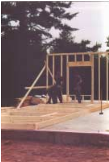
La charpente est montée
