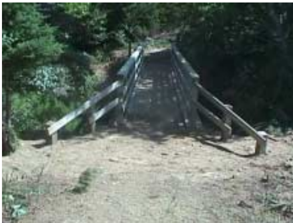
Pont non réglementaire de 47' construit à Guysborough County, N.-É., par la Troupe Falaise
