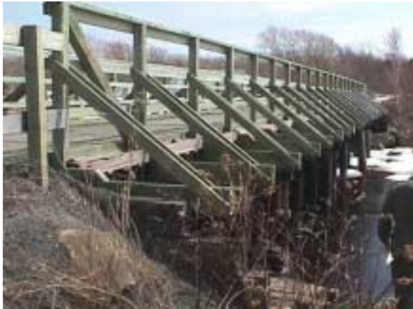
Port Hood - Réfection du tablier des ponts du Cap Breton par la Troupe Mémorial.
