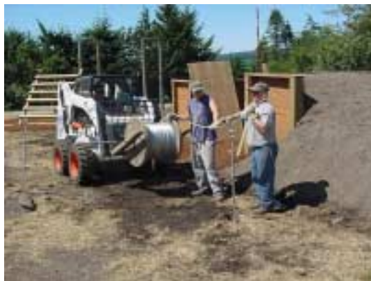
Déroulant du câble avec le Bobcat
