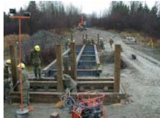
Les sapeurs de l'Escadron terminent l'assemblage de la structure d'acier et la mise en place des culées du pont.
