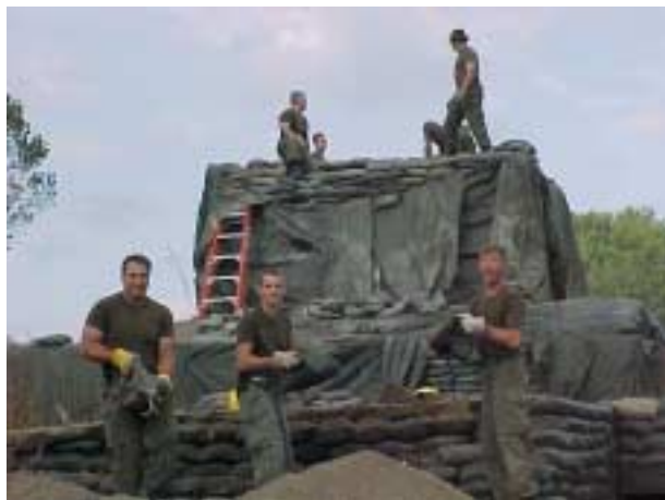
Démolition de bunker
