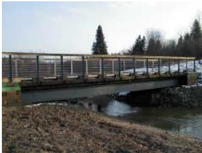
Photo du pont terminé.
