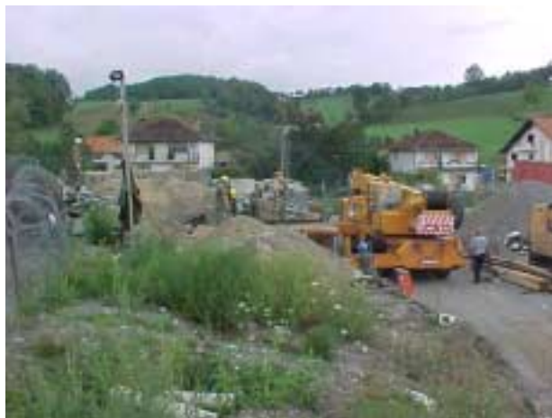
Démolition des travaux de défense
