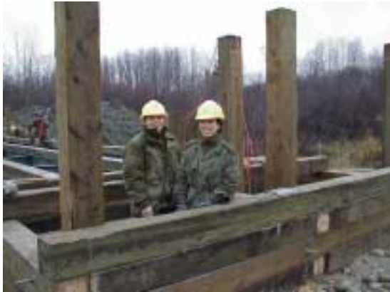
Sapeur Cynthia Bougie-Laliberté, diplômé en charpenterie discute de la fabrication des culées du pont avec son commandant de section, caporal Marie-Eve Desrosiers.
